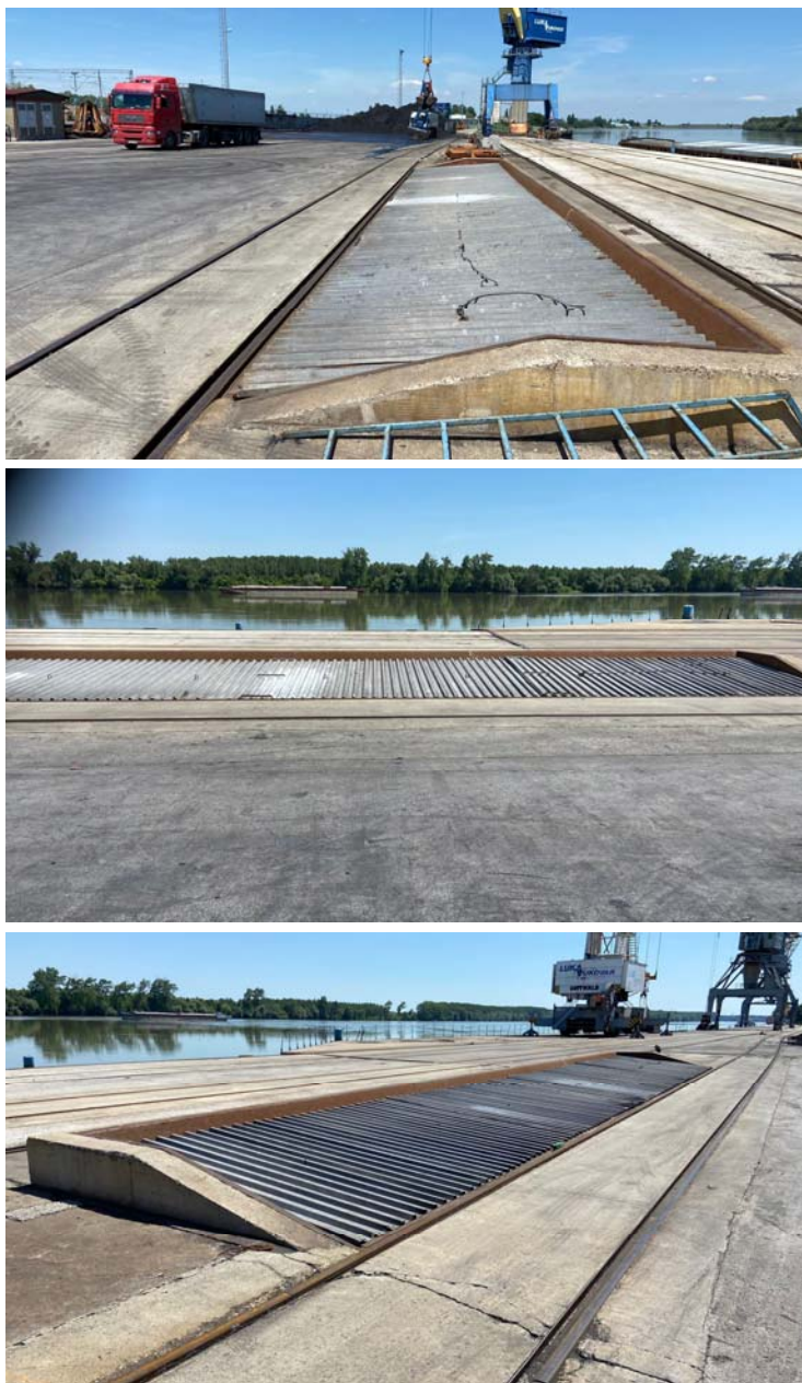
Slika 1-6 Usipni koševi za rasute terete na prostoru postojeće luke
