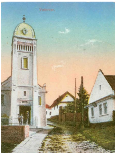
SLIKA 16: Stara sinagoga, kasnije kalwinska crkva s prvim izgrađenim armiranobetonskim tornjem u Hrvatskoj, srušena 1965. Izvor: www.vucafe.org
