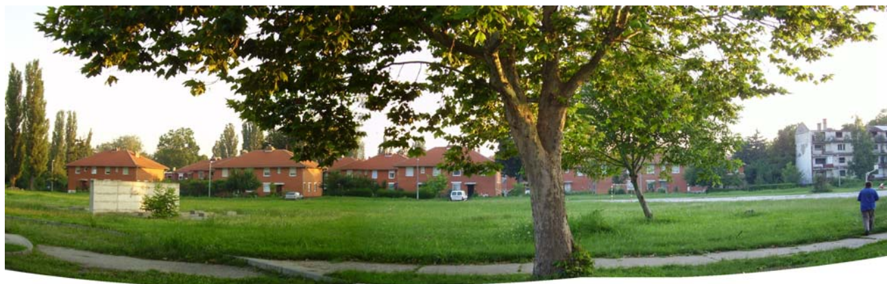
OBNOVLJENE ZGRADE U BOROVU NASELJU
