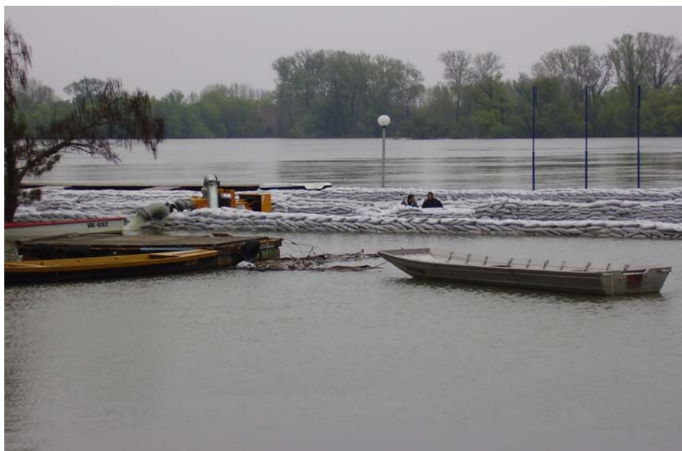
ZEČJI NASIPI I CRPKE ZA ZAŠTITU OD POPLAVE
