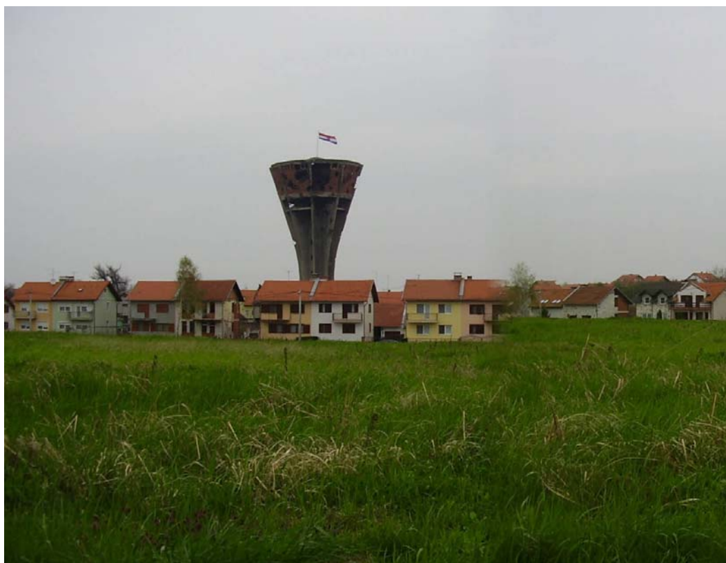
POGLED NA OBNOVLJENE STAMBENE KUĆE I NEOBNOVLJENI VODOTORANJ
