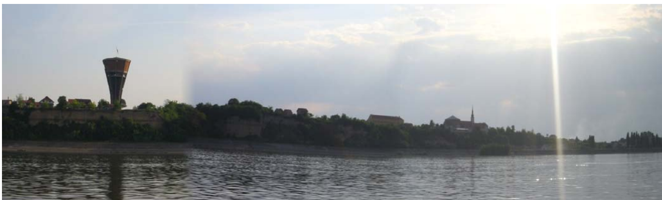
POGLED NA VODOTORANJ
