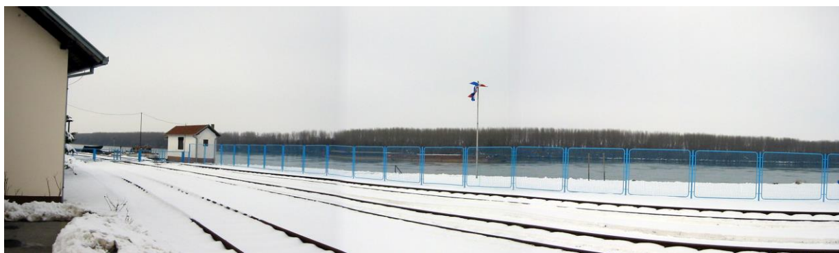
ŽELJEZNIČKA INFRASTRUKTURA LUKE VUKOVAR
