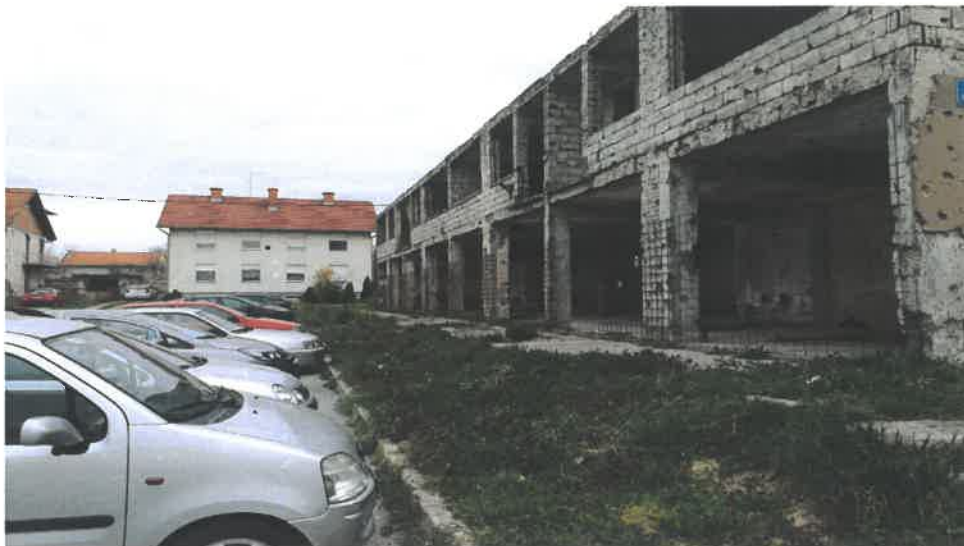
Slika 3. Očišćena i ograđena lokacija u Sotinskoj ulici
